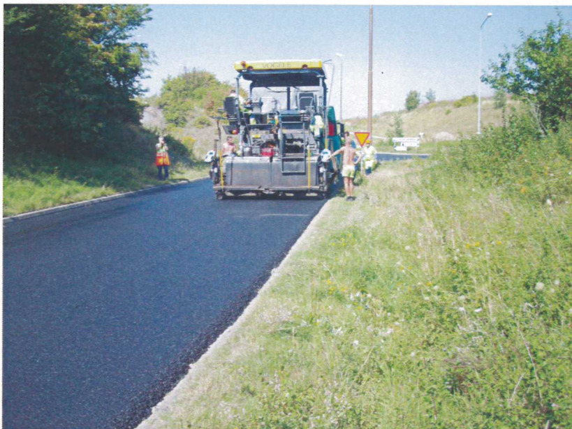
Figur 16 . Läggnig av asfaltmassa med Rediset WMX. Ingen synlig asfaltrök.
