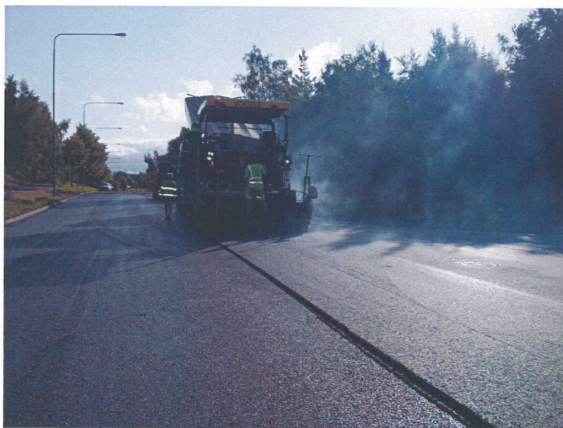
Figur 15 Läggning av referensytan. Observera asfaltröken.
