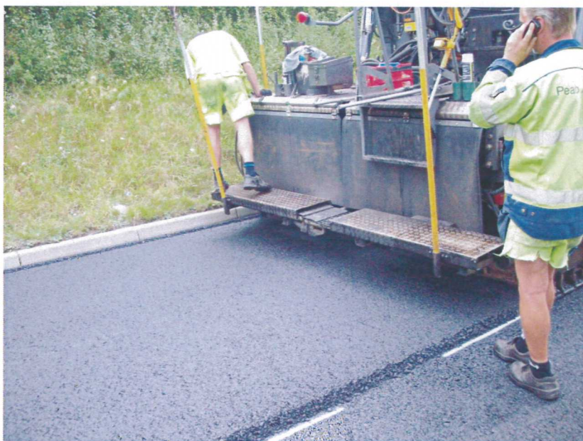
Figur 17. Läggnig av asfaltmassa med Cecabase RT 945. Ingen synlig asfaltrök.
